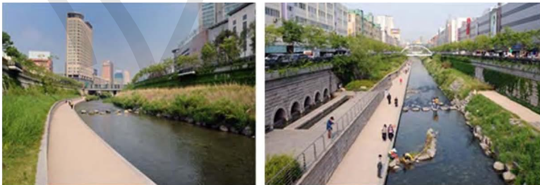
图 10.2.5-4 现状河道改造示意图（两侧用地受限-打造亲水平台）示意图
