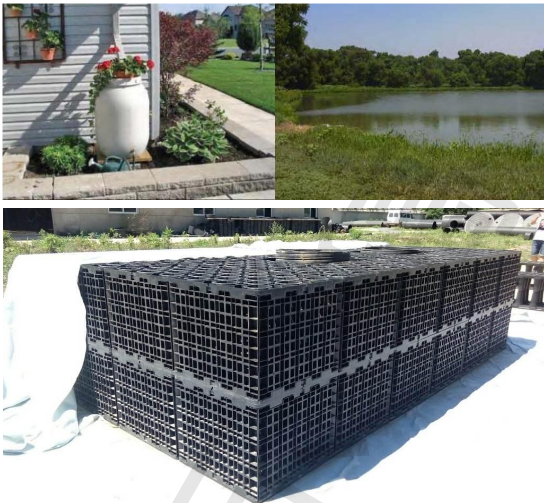
图 6.2.8 雨水罐、雨水湿塘、雨水调蓄模块实景图
