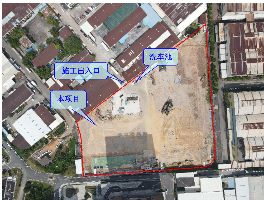
照片1 项目整体施工现状
