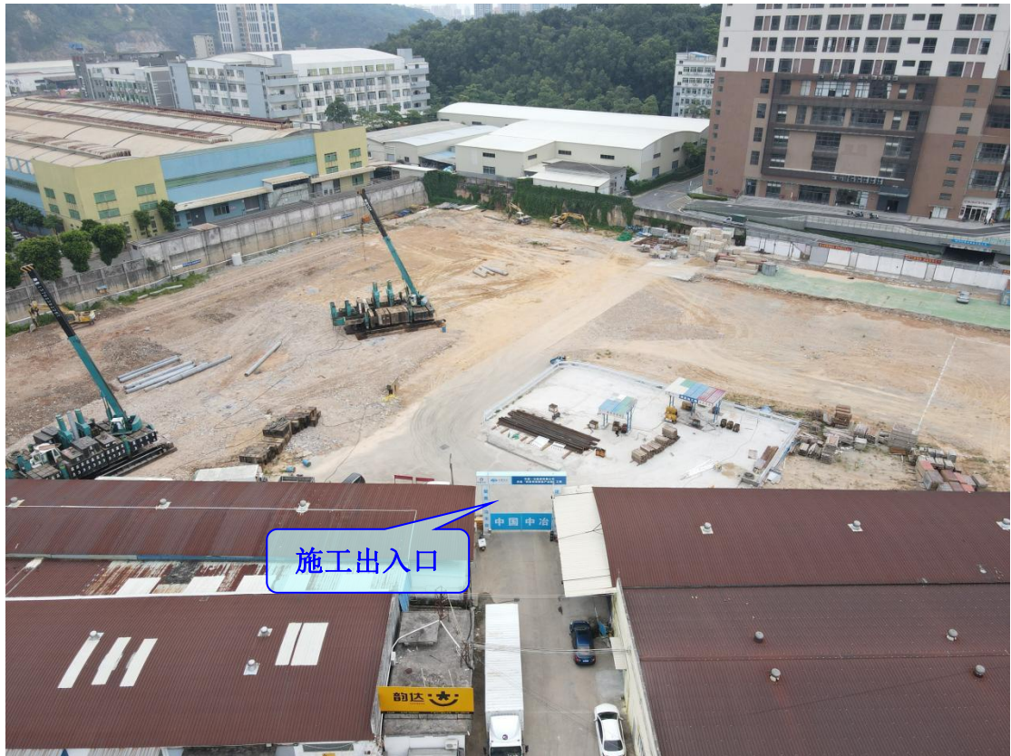
照片2 项目施工出入口
