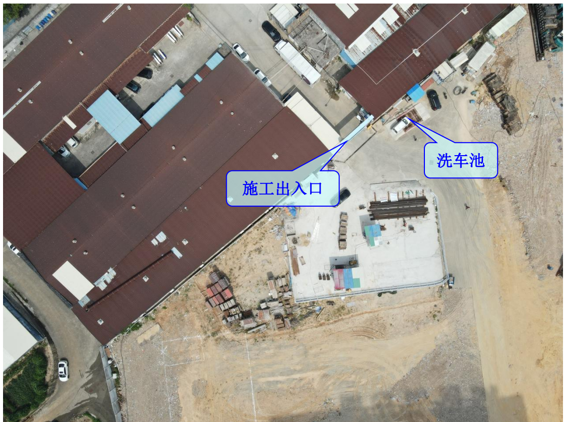
照片3 项目施工出入口
