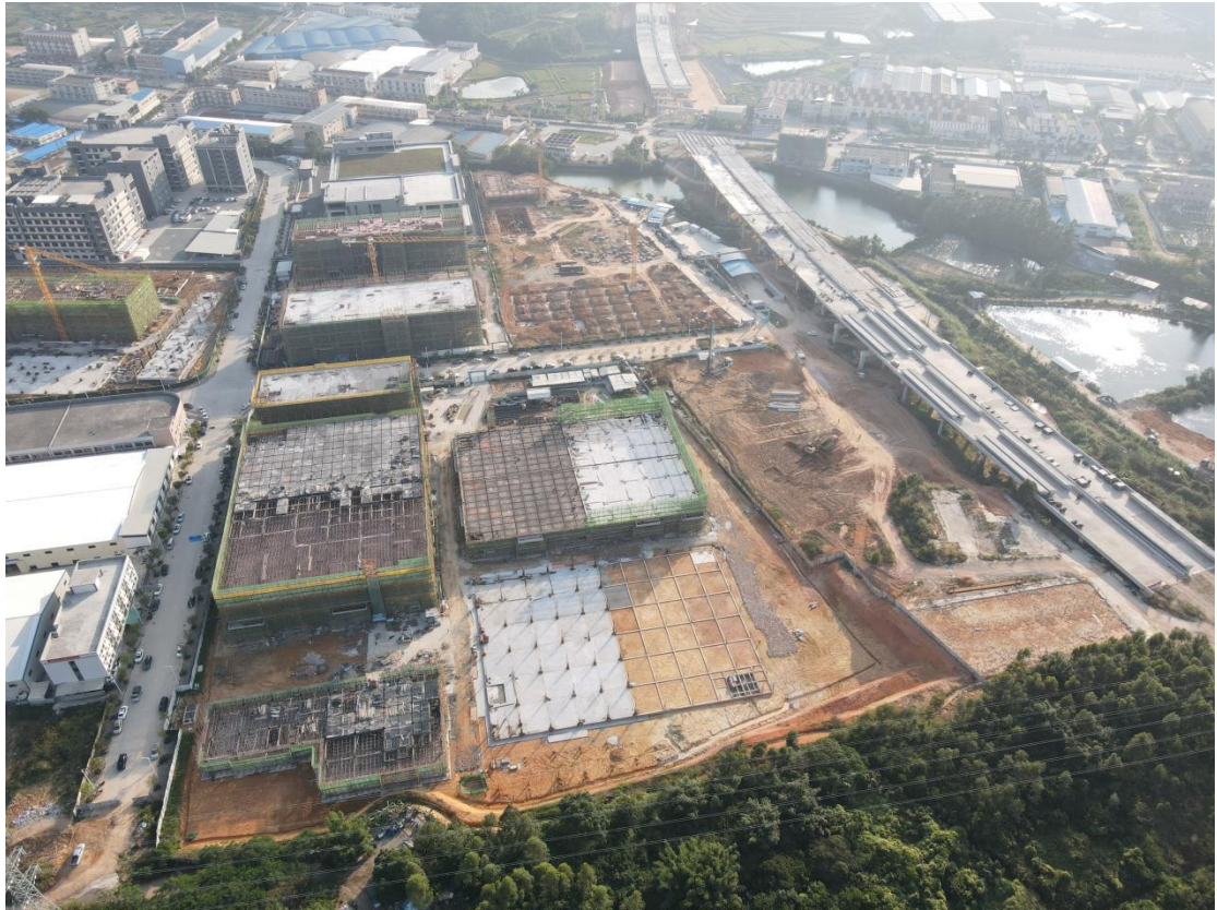
照片3 项目整体施工现状
