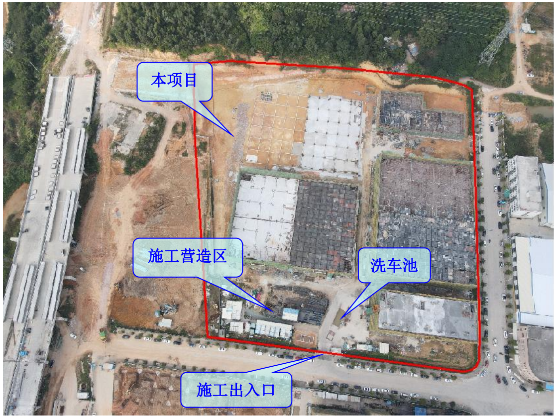
照片1 项目整体施工现状
