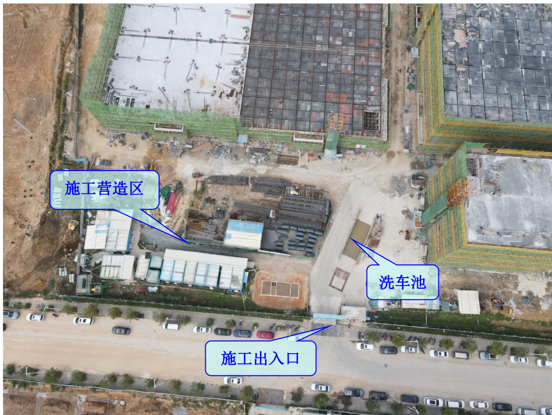
照片2 项目施工出入口
