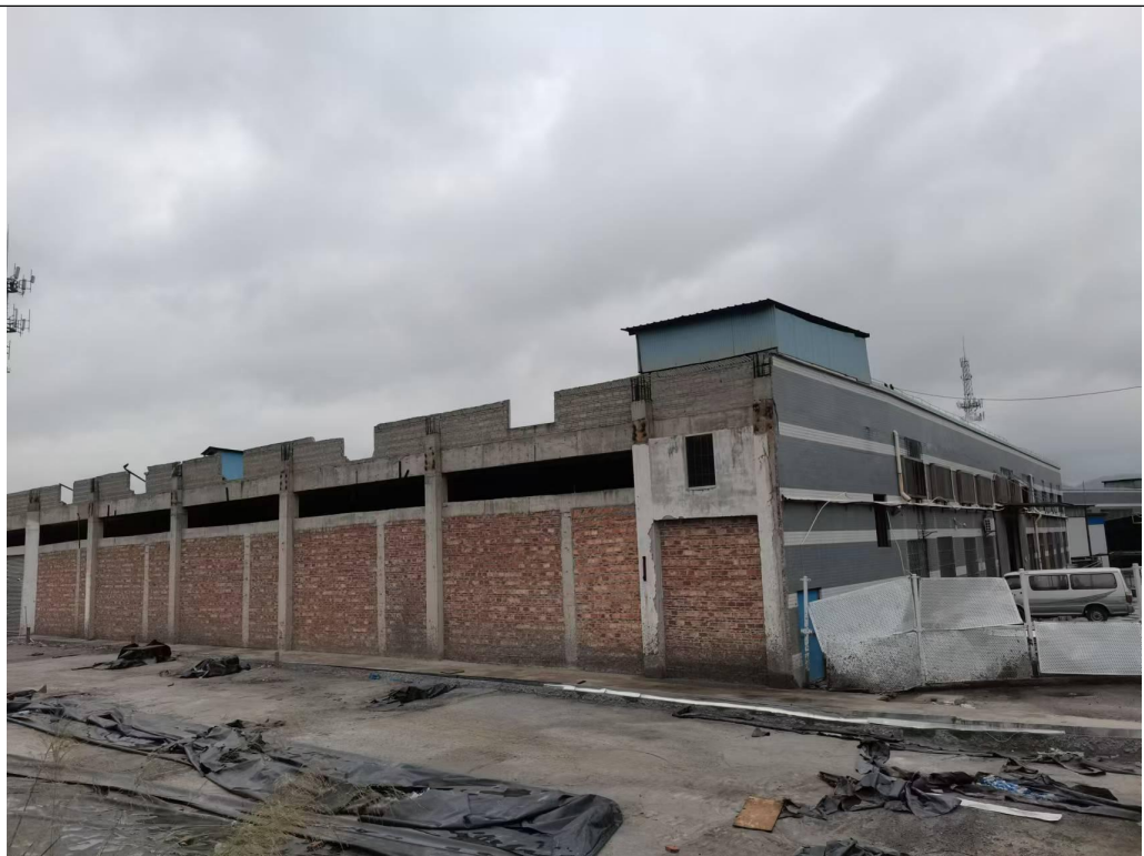
珠江皮革实业有限公司（范围内的建筑物现状已被拆除）
