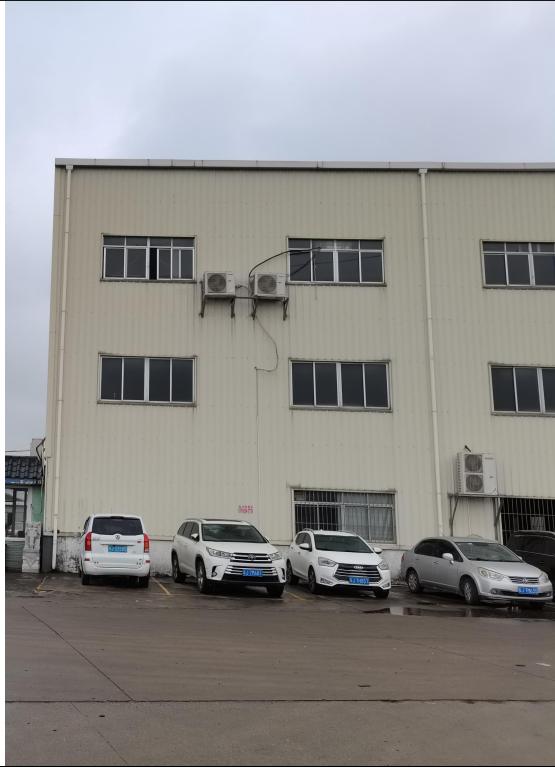
江门市盛誉金属制品有限公司建筑物
